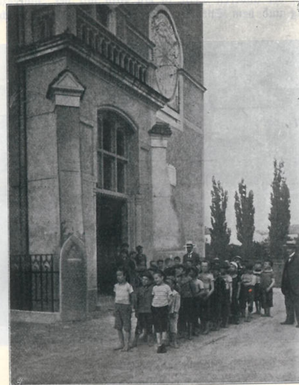
Eingang in das Schulhaus am Grieskai.
