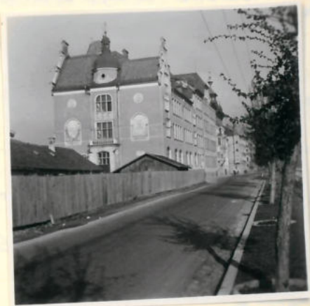
Das Schulgebäude mit der gefährlichen Straßendecke.
