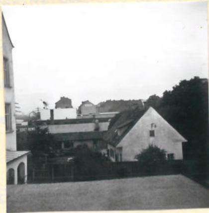
Das im Vordergrund stehende Stadthaus wurde abgerissen u. Der Platz f. ein Gymnase vorbereitet.
